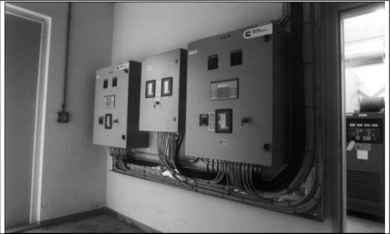
Главные контроллеры MC150 в составе автоматической системы параллельного подключения
