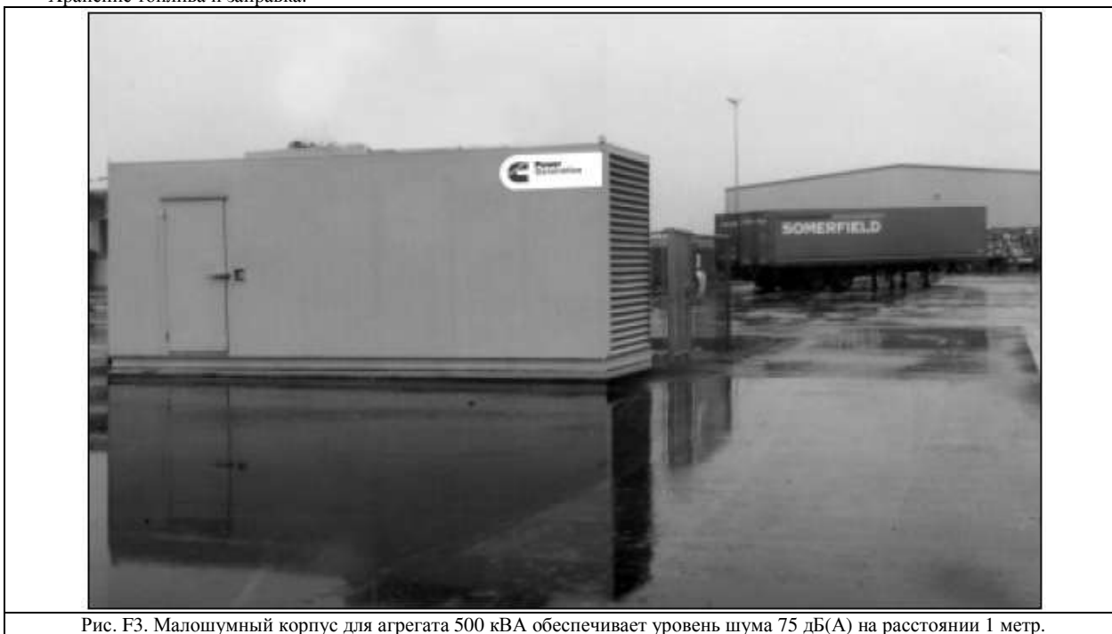
Рис. F3. Малошумный корпус для агрегата 500 кВА обеспечивает уровень шума 75 дБ(А) на расстоянии 1 метр.
