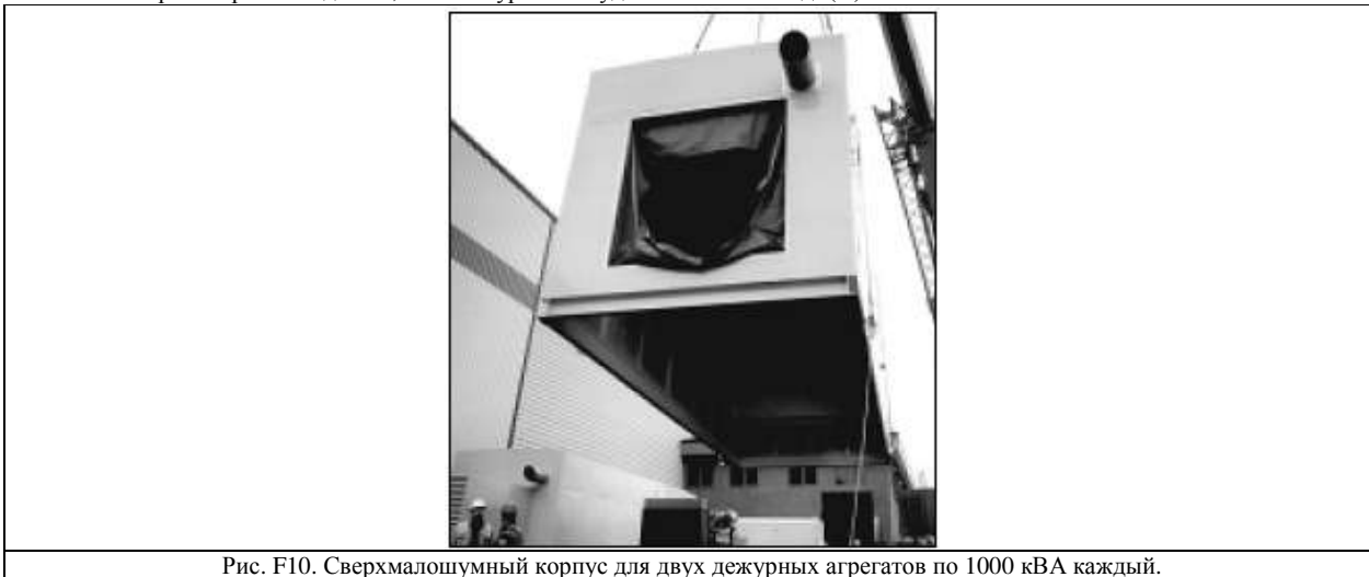
Рис. F10. Сверхмалозумный корпус для двух дежурных агрегатов по 1000 кВА каждый.
