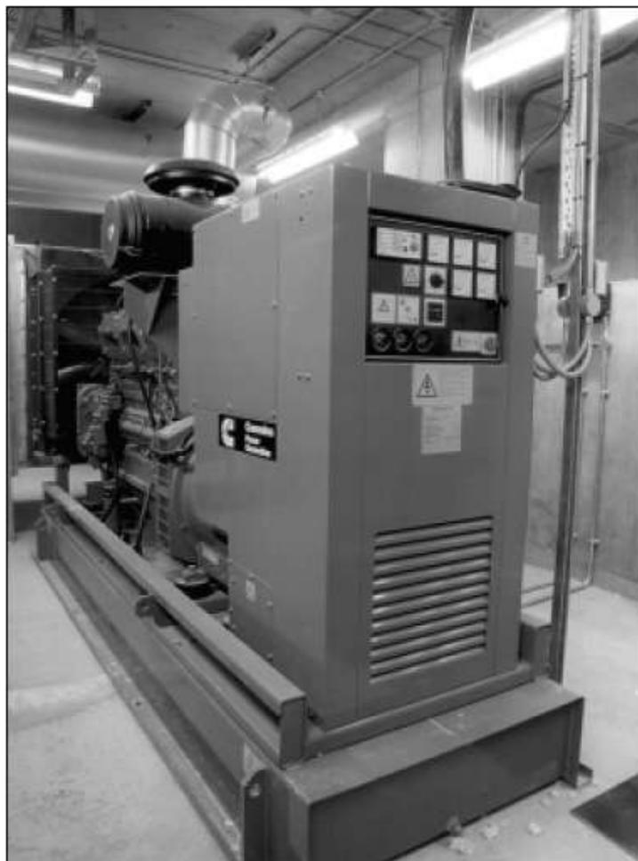
Стандартный генератор на 300 кВА с основным топливным баком в типовом машинном зале
