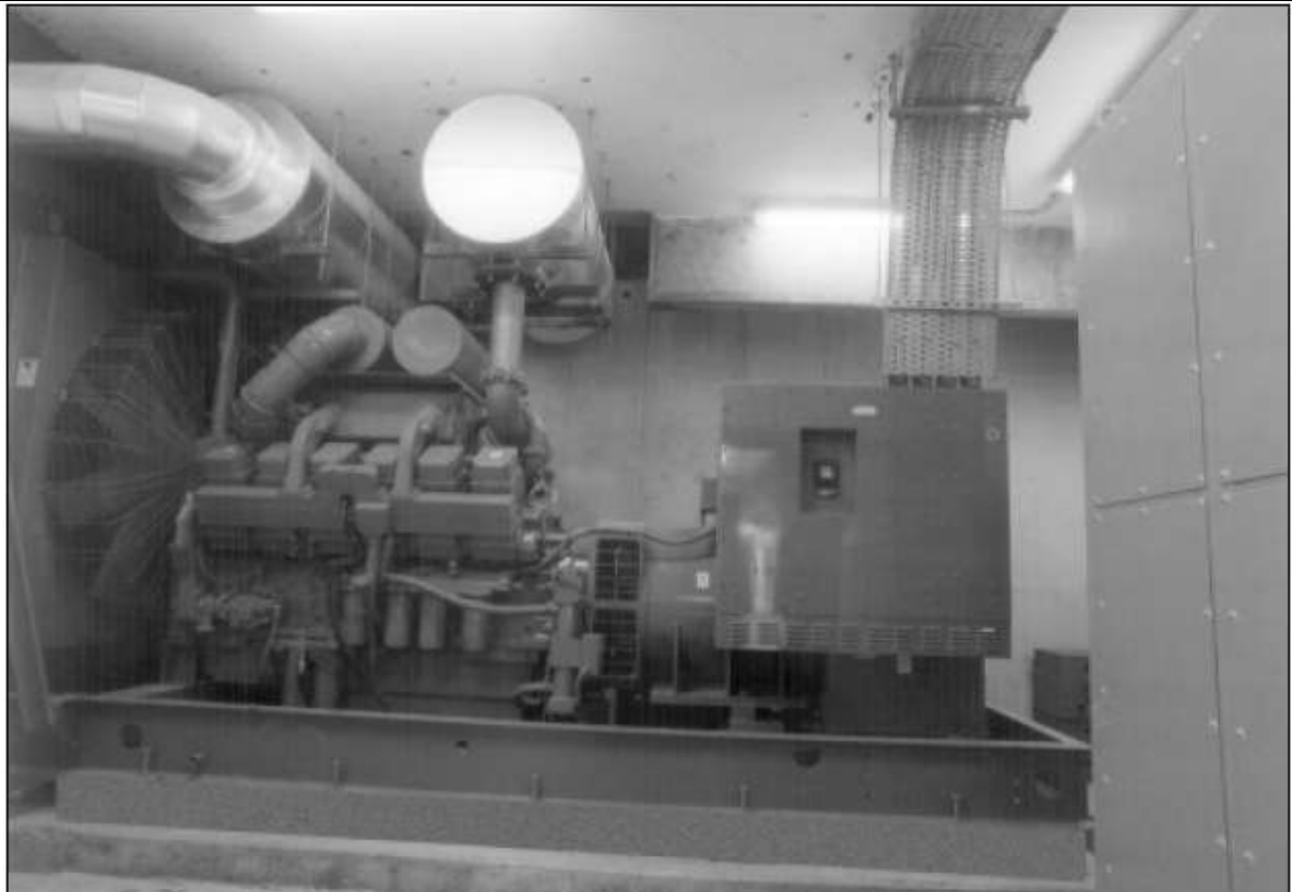
Верхняя подводка кабеля. Панели управления допускают верхнюю или нижнюю подводку. Точная верхняя подводка кабеля к модулю управления с использованием перфорированного стального кабельного желоба и потолочной подвески.
