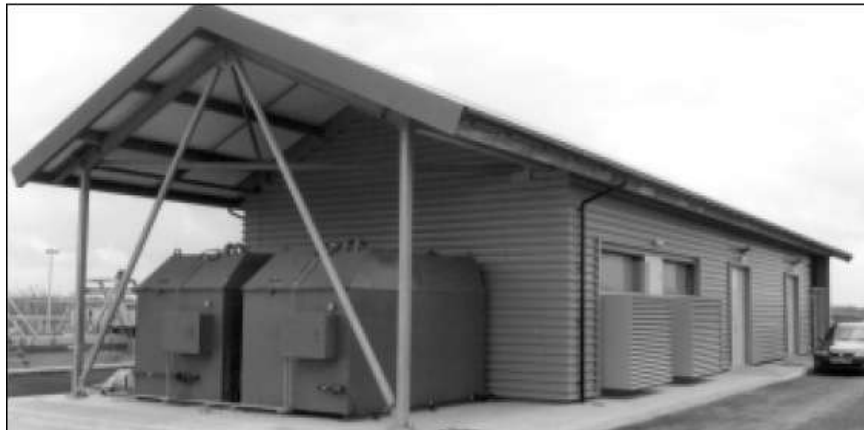
Хороший пример строения, специально предназначенного для размещения двух генераторов на 1000 кВА каждый с наружными шумоглушителями
