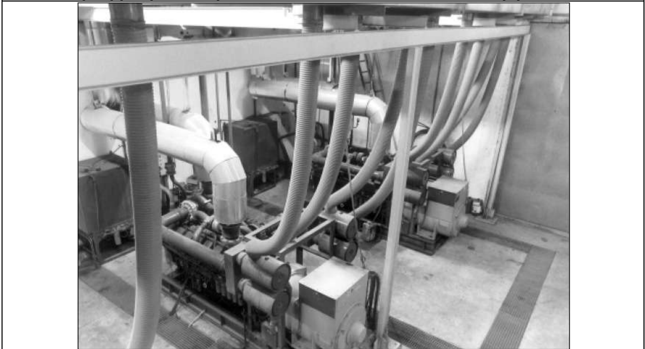
При установке агрегатов в подвале гибкие воздуховоды обеспечивают подачу холодного воздуха к впускному воздухоочистителю
